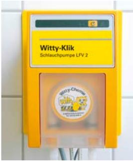
Das Witty-Klik LFV 2 ermittelt permanent die Reiniger-Konzentration. Dadurch wird der Spüllauge exakt die Menge an Reiniger zudosiert, die für ein hygienisch sauberes Geschirr nötig ist. Witty-Klik LFV 2 sorgt für wirtschaftliches und bedarfsgerechtes Dosieren bei Eintank- und Mehrtankmaschinen.
